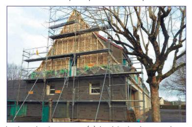
bardage du pignon exposé à la pluie, bardage en plaque fibrociment contenant de l'amiante, accompagné de la pose d'un isolant. Ces travaux sont également subventionnés à 70 % par l'État.
